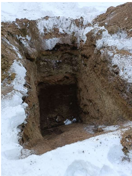
Kuva 2. Tutkimuspiste SW2. Tutkimuspisteessä ei havaittu mitään poikkeavaa.
